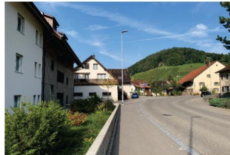
Verzweigung Riniker- / Villigerstrasse, Blick nach Westen
