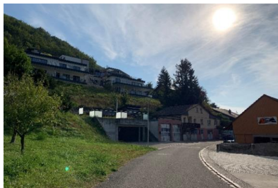
Oberdorfstrasse, Blick auf Geissberg
